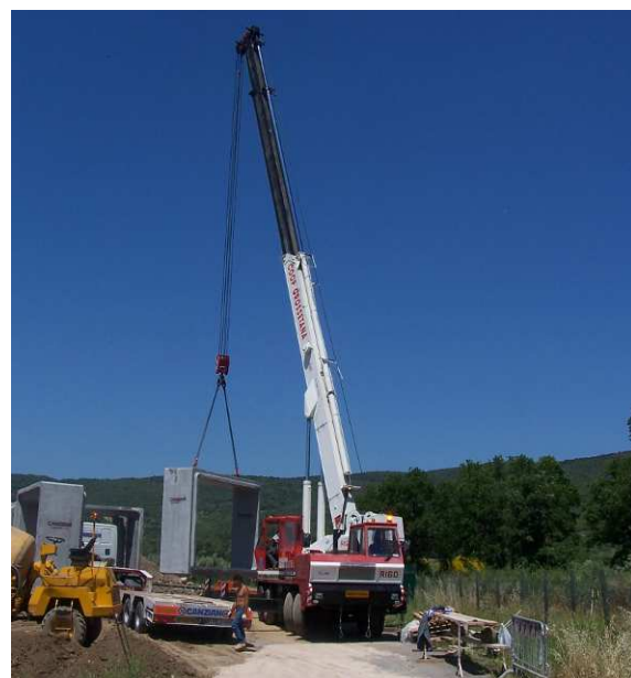
Arrivo dei manufatti scatolari in cantiere
