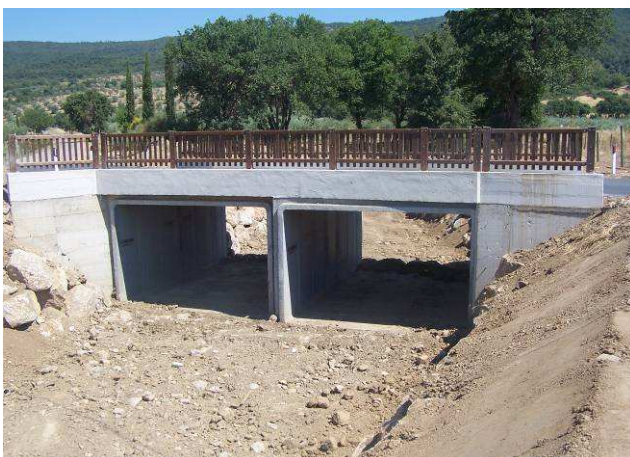
Lavoro finito vista di valle
