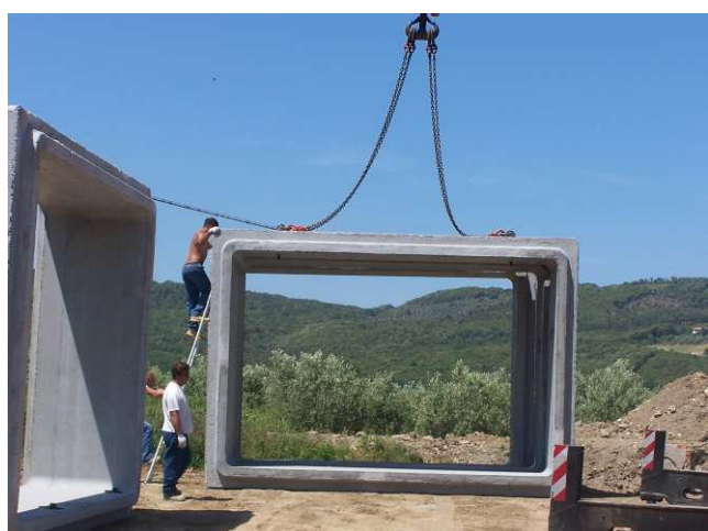
Movimentazione dei manufatti scatolari
