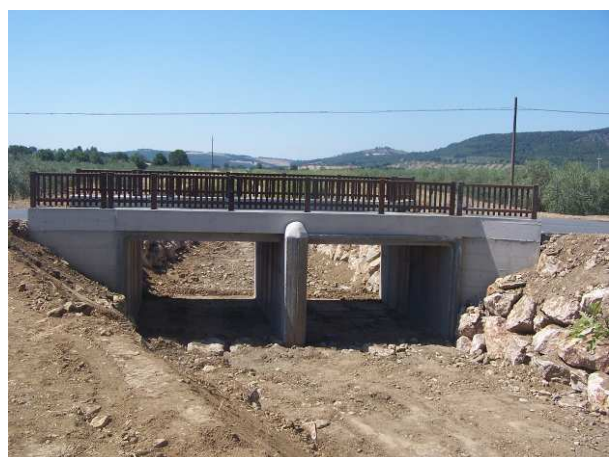
Lavoro finito vista di monte
