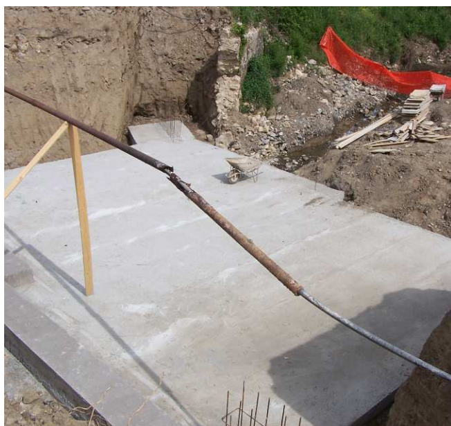
Soletta di appoggio dello scatolare
